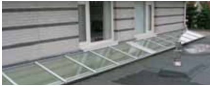
Lessenaarsdak tegen muur (LDM)
